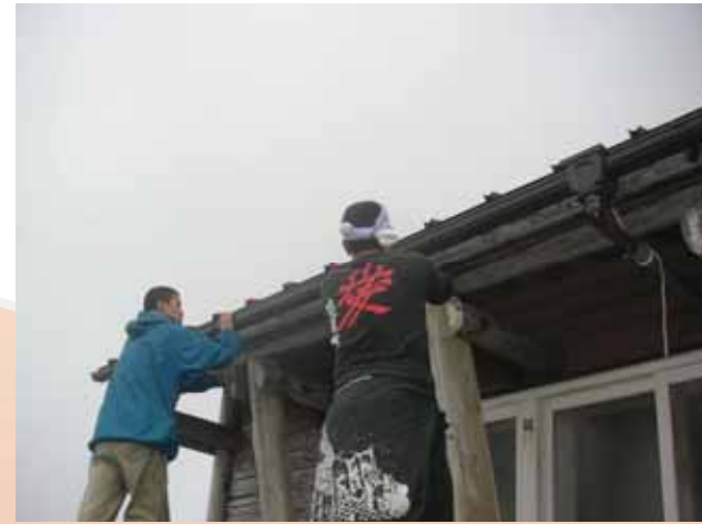
10月20日 殿が池避難小屋の「雨水集水システム」撤去作業の様子
