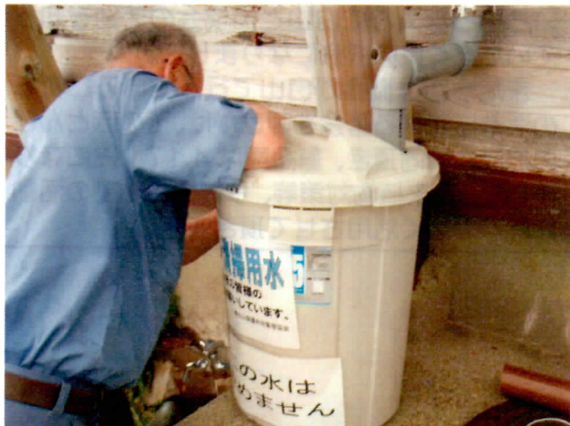
雨水集水タンクを設置
